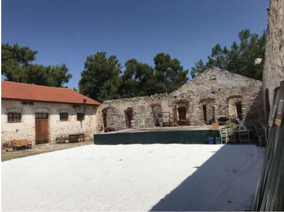
Εικόνα 4. Ανατολικό τμήμα του αίθριο του κτιριακού συγκροτήματος των αποθηκών.
