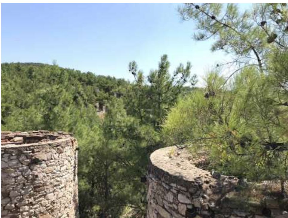
Εικόνα 11. Δύο από τις κυκλικές ορθοκαμίνους του συγκροτήματος εμπλουτισμού του μεταλλεύματος.
