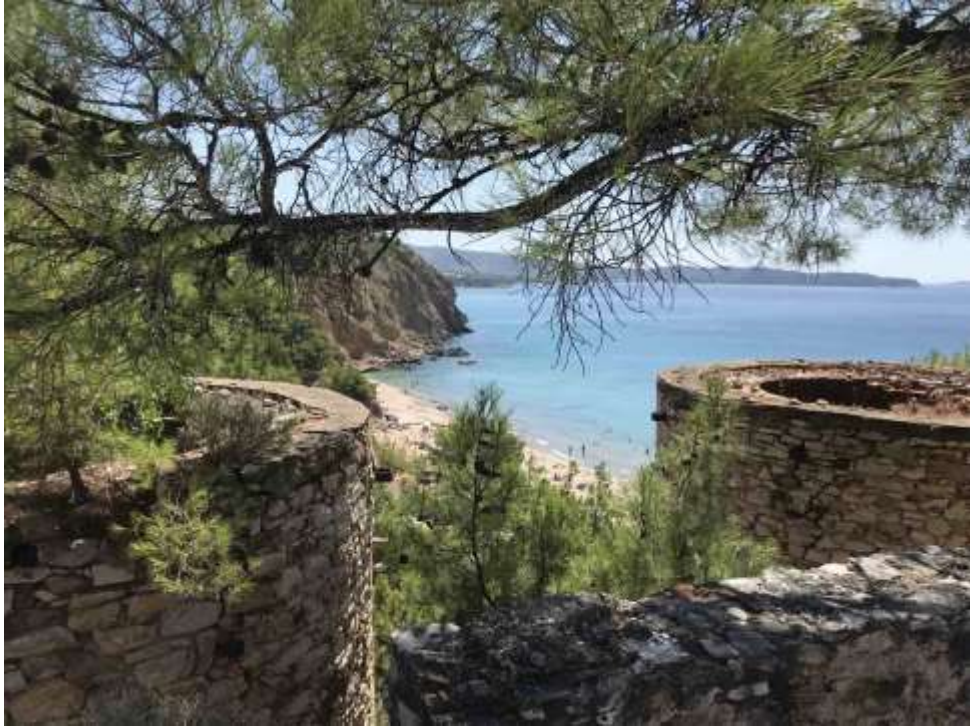
Εικόνα 12. Δύο από τις κυκλικές ορθοκαμίνους του συγκροτήματος εμπλουτισμού του μεταλλεύματος και στο βάθος η παραλία Μεταλλεία.
