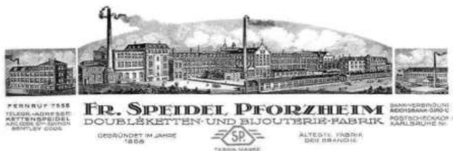
Εικ. 1β: Το βιομηχανικό συγκρότημα Speidel στο Pforzheim της Γερμανίας (Πηγή: ΙΑΕΤΕ).
