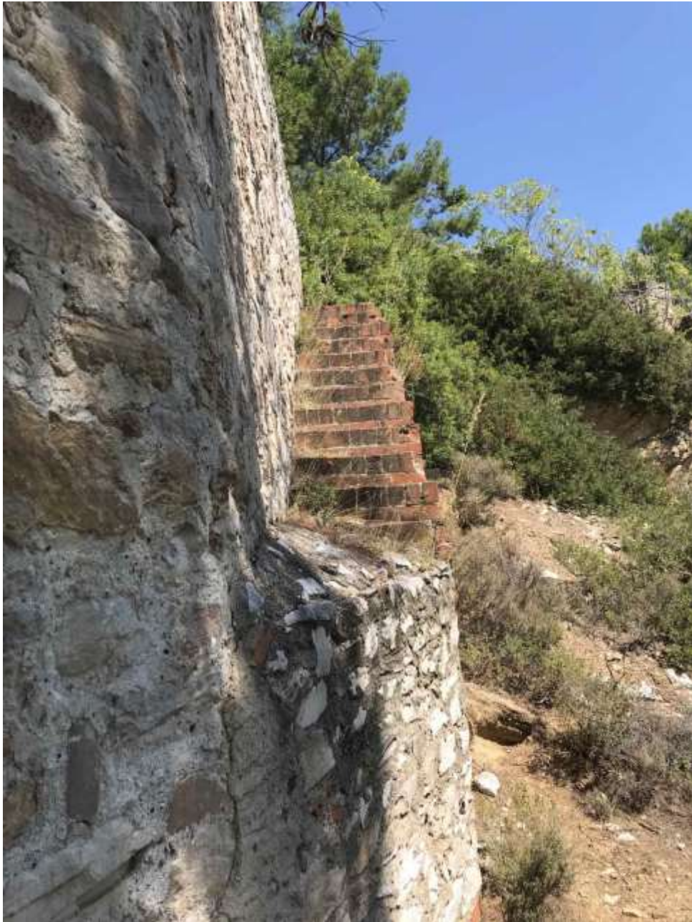
Εικόνα 10. Σκάλα διακίνησης εργατών μεταξύ του κλίτους των ορθοκαμίνων και του ανώτερου κλίτους στο συγκρότημα εμπλουτισμού του μεταλλεύματος.
