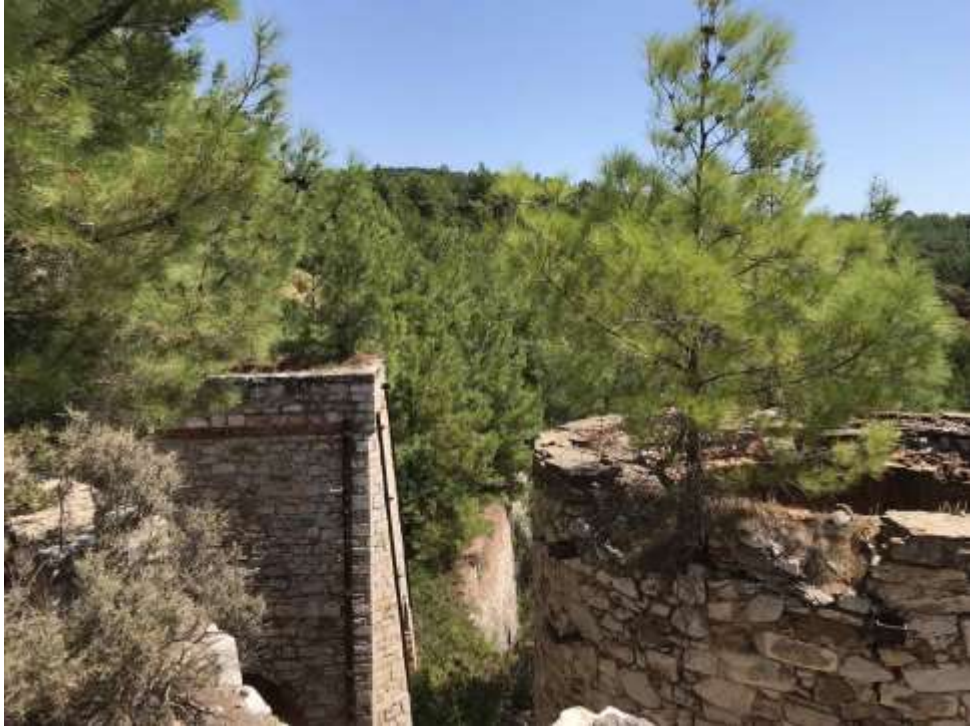
Εικόνα 7. Ορθοκάμινοι του συγκροτήματος εμπλουτισμού του μεταλλεύματος.
