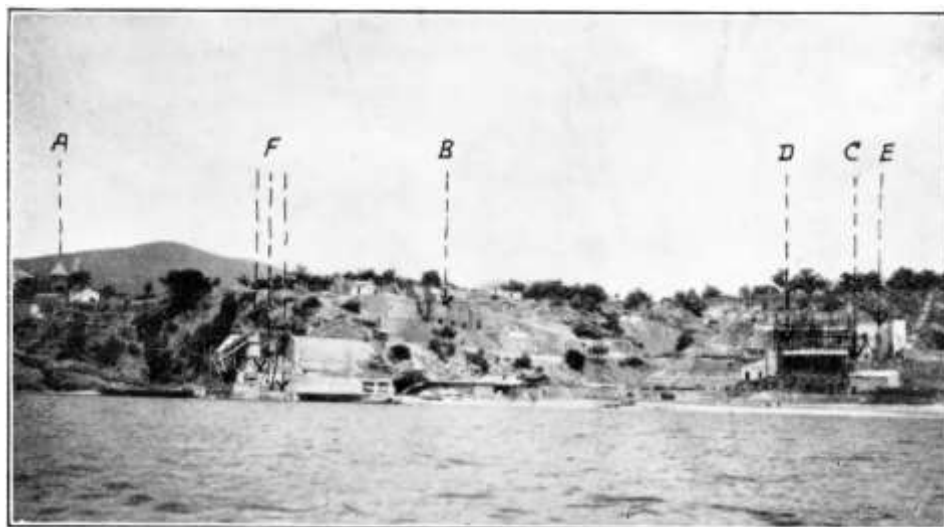
Εικ. 1: Μεταλλευτικό Συγκρότημα Θάσου. Επεξήγηση της διάταξης των τεχνικών μονάδων επεξεργασίας: Α) Διοίκηση (παλατάκι), Β) Κάμνοι, C) περιστρεφόμενοι φούρνοι, D) χώροι αποθήκευσης οξειδίων, E) Ηλεκτρικός σταθμός, F) εγκαταστάσεις φόρτισης (πηγή: https://commons.wikimedia.org/wiki/Minengesellschaft Fr. Speidel ).
