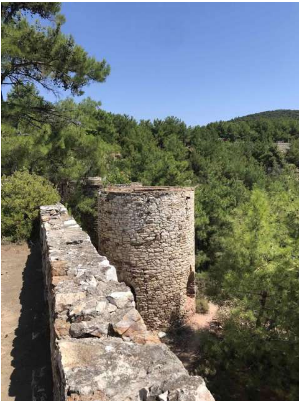
Εικόνα 9. Αποψη μιάς ορθοκαμίνου από το ανώτερο κλίτος του συγκροτήματος εμπλουτισμού του μεταλλεύματος.
