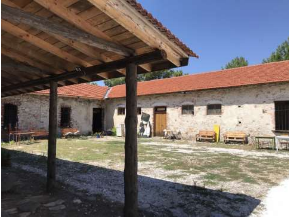
Εικόνα 5. Δυτικό τμήμα του αίθριο του κτιριακού συγκροτήματος των αποθηκών.
