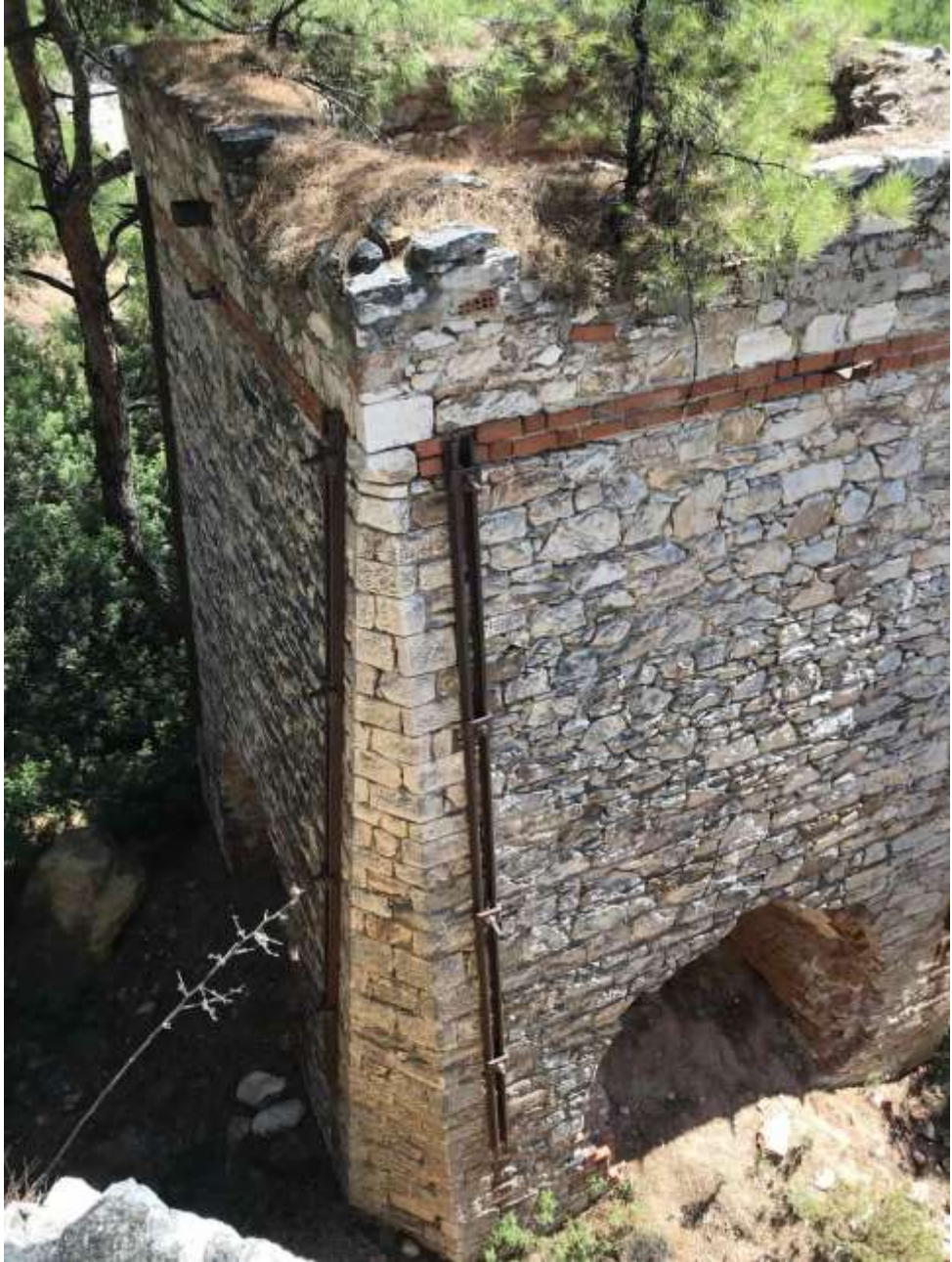
Εικόνα 8. Ορθοκάμινος του συγκροτήματος εμπλουτισμού του μεταλλεύματος.
