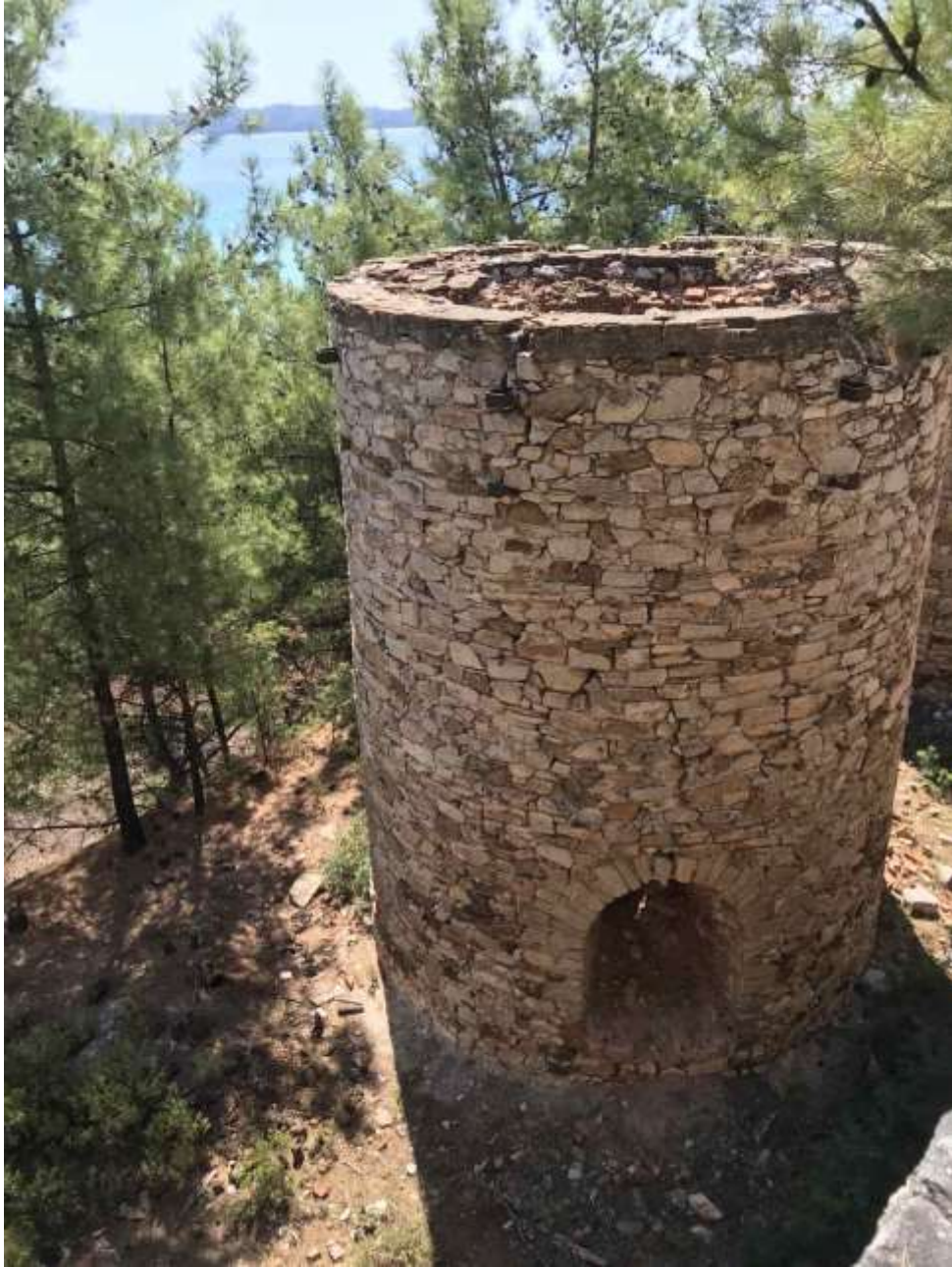
Εικόνα 6. Ορθοκάμινος του συγκροτήματος εμπλουτισμού του μεταλλεύματος.
