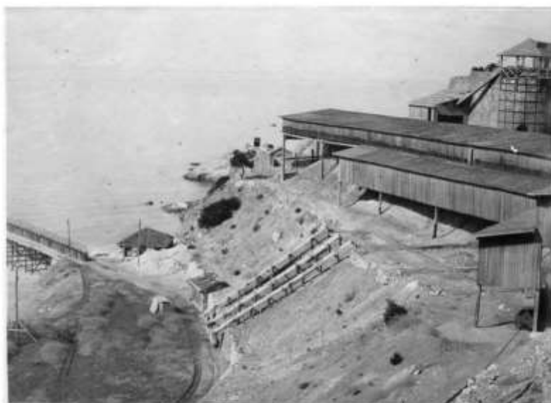
Εικ. 4: Δυτικό τμήμα εγκαταστάσεων: ορθοκάμινοι δεξιά και προβλήτα μεταφόρτωσης αριστερά (πηγή: https://commons.wikimedia.org/wiki/Minengesellschaft Fr. Speidel ).
